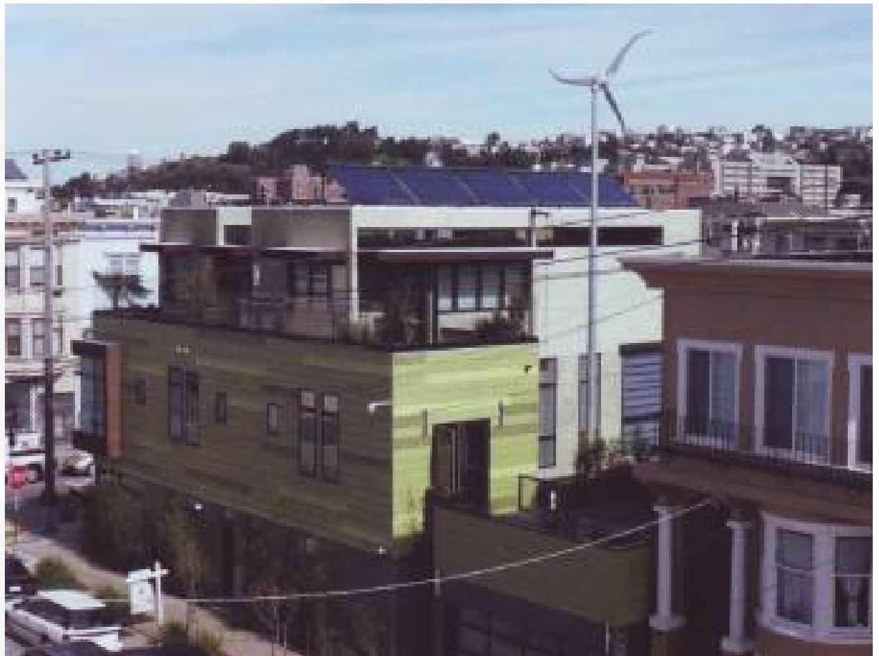
Turbina “Skystream 3.7”, 1.8 kW Califórnia
