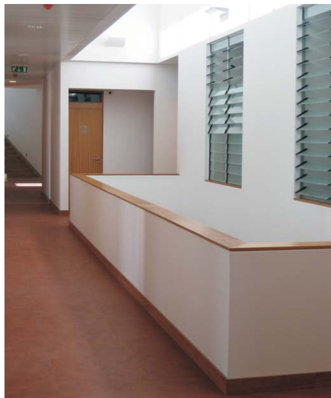
Corredor de distribuição e vãos interiores translúcidos de lâminas reguláveis
