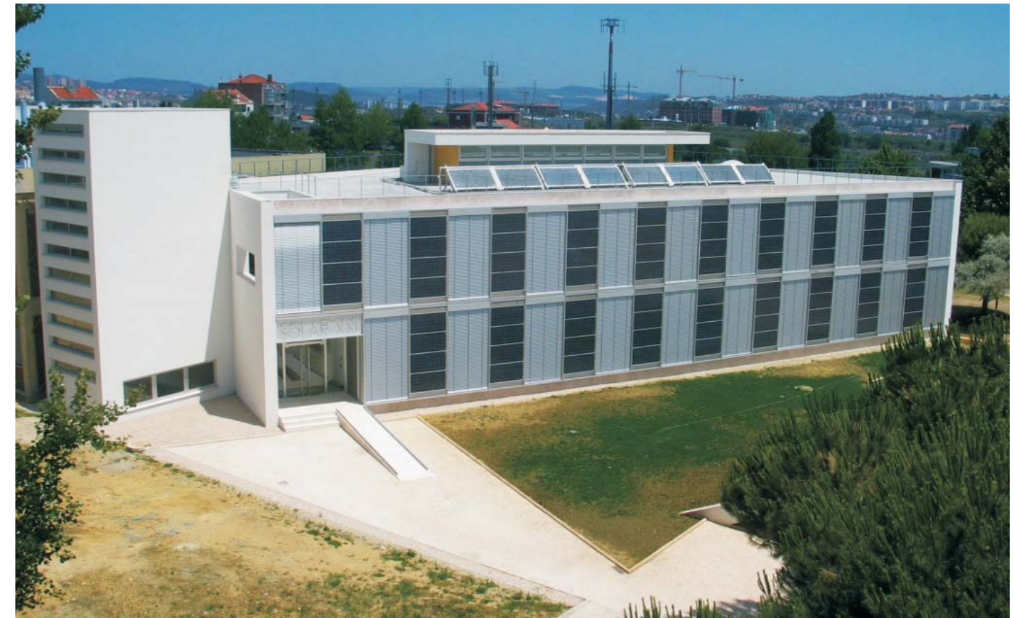
Vista geral da fachada Sul
