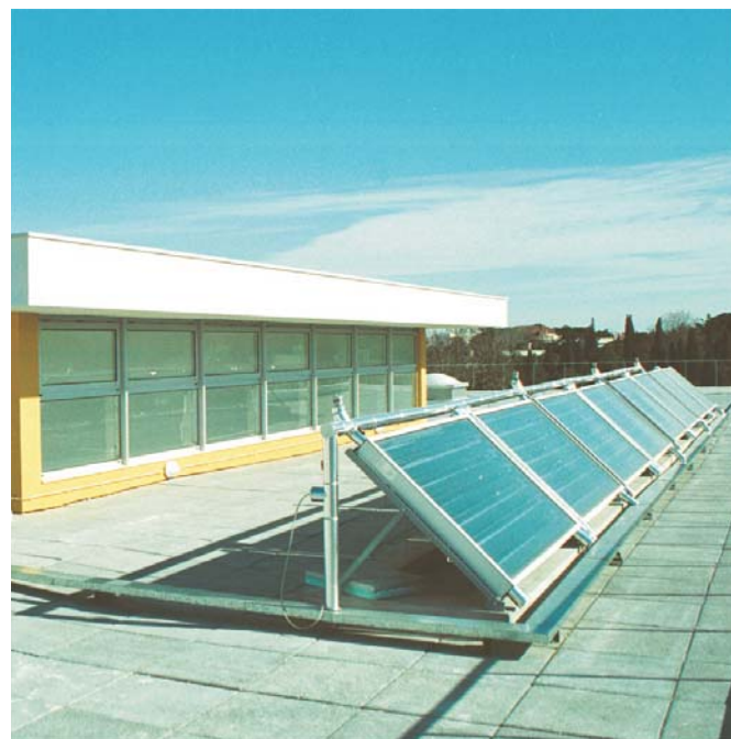
Colectores solares na cobertura e vão exterior para iluminação e ventilação
