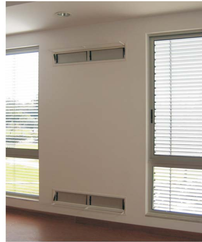
Aspecto dos orifícios de ventilação no interior das salas viradas a Sul
