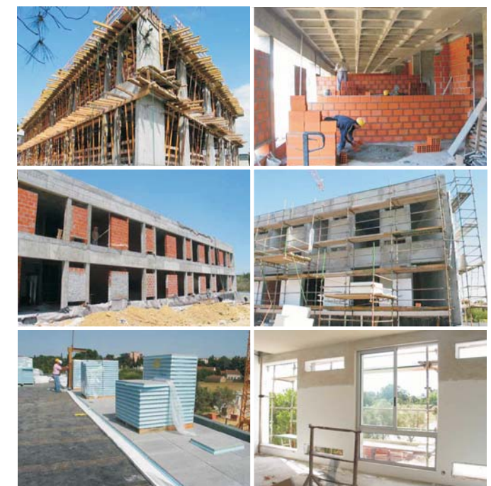
Aspectos da fase de construção
