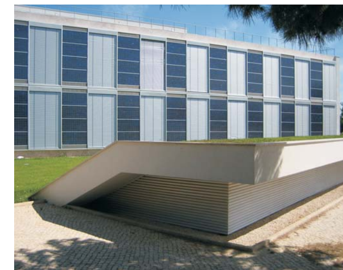
Aspecto exterior do poço de admissão de ar com grelha contínua
