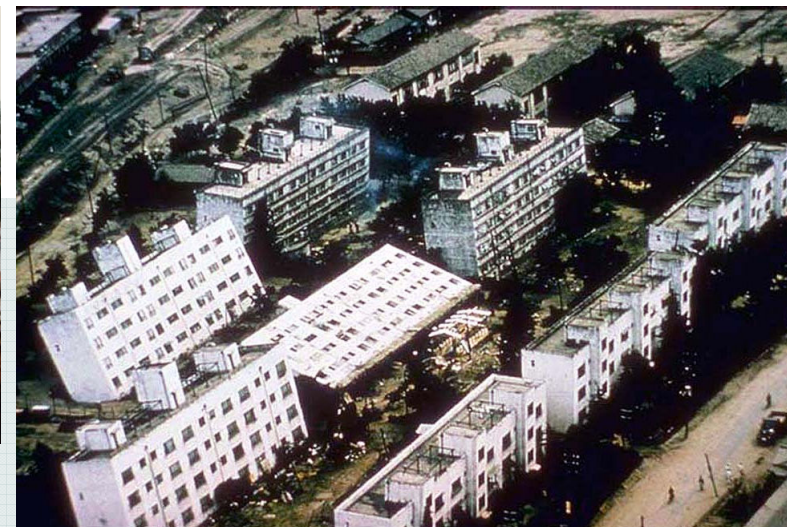
Liquefacção dos terrenos
