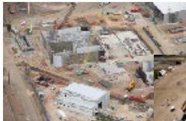
ETA de Bundamba
