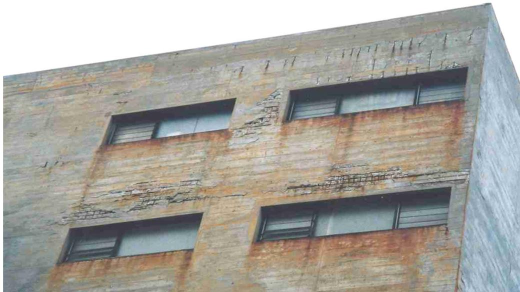
**Aspecto da superfície do betão afectada pela corrosão das armaduras**
