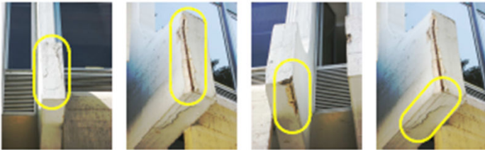
1.A -> Reparação Integral do topo das costelas. 1.B -> Reparação local de arestas. 1.C -> Reparação local de um canto.
