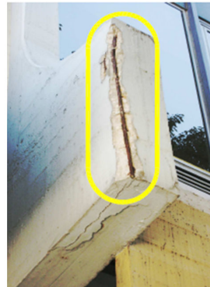
1.A -> Reparação integral do topo das costelas.
