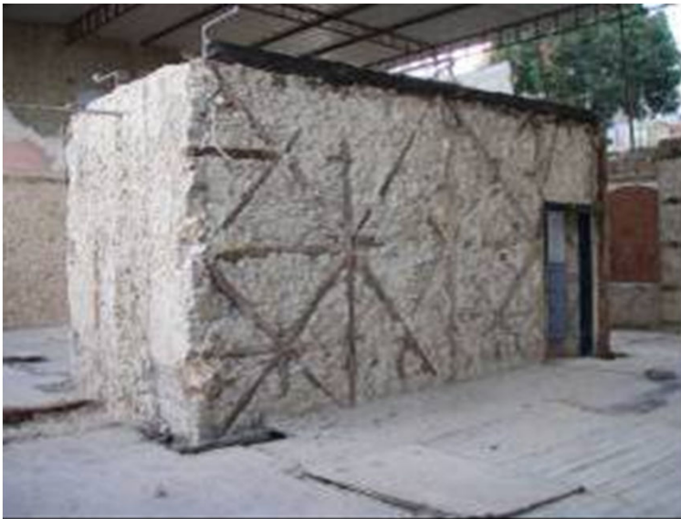
Edifício na Rua de São Mamede
