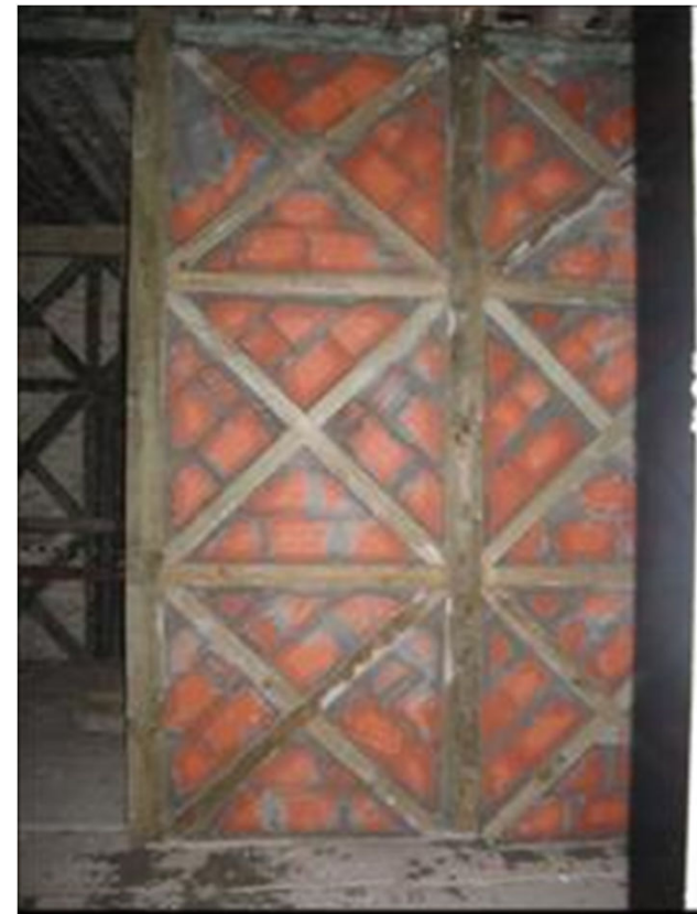
Execução de novas paredes tipo frontal
