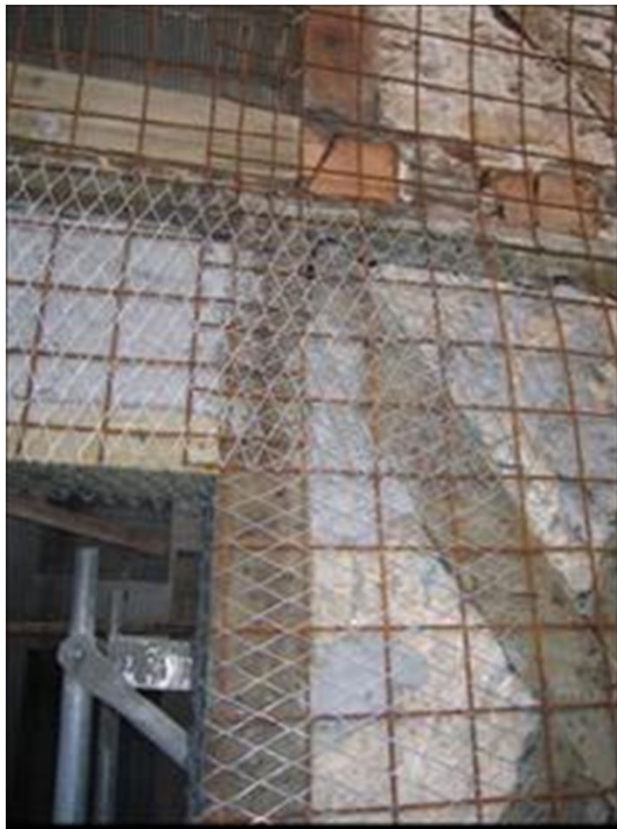
Reforço de paredes existentes com reboco armado
