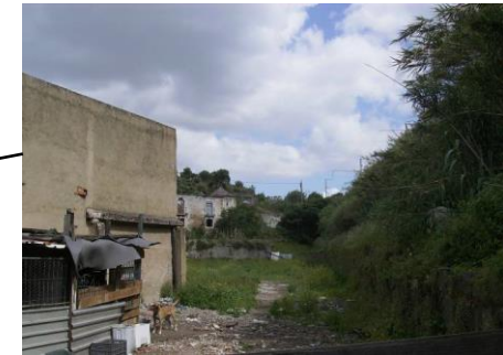
Início do túnel
