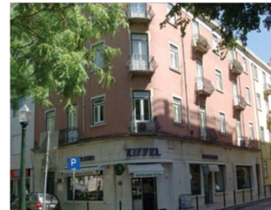
Figura 03 Vista geral do edifício
