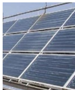
Figura 15 Coletor Concentrador Parabólico Composto (Fonte: LNEG)
