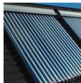
Figura 16 Coletor de Tubos de Vácuo (Fonte: LNEG)
