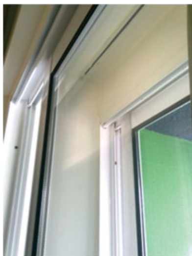
Figura 12 Pormenor de vão duplo com janelas de vidro duplo
