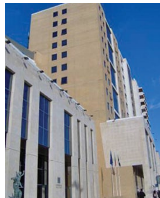
Figura 02 Edifício municipal Campo Grande 25
