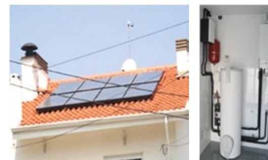
Figura 18 Sistema Solar Térmico de Circulação Forçada (Fonte: Junkers)
