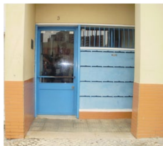
Figura O4 Pormenor da entrada principal do edifício
