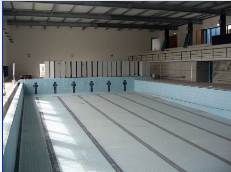
Piscina pública. Encontra-se em fase de construção.
