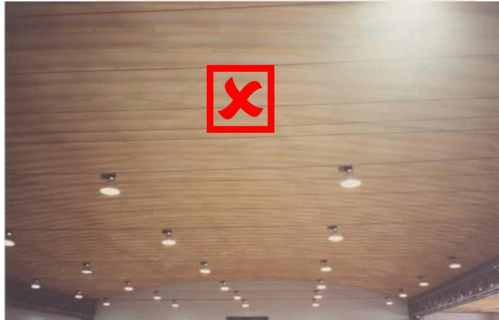
Isolamento térmico projectado na face inferior (interior) de cobertura leve
