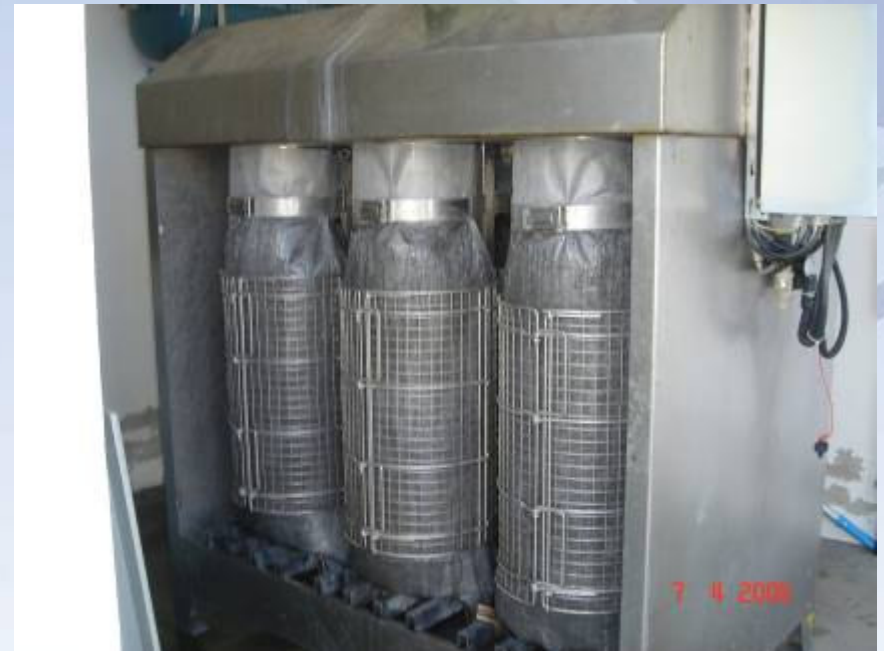
Desidratação Mecânica de lamas Sacos Draidmad
