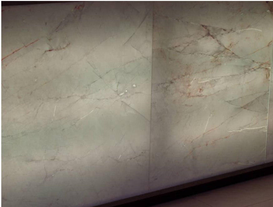
Fig.6 Painéis de pedra natural reforçados com placa de vidro
