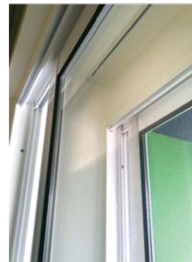
**Figura 15** Pormenor de vão duplo com janelas de vidro duplo
